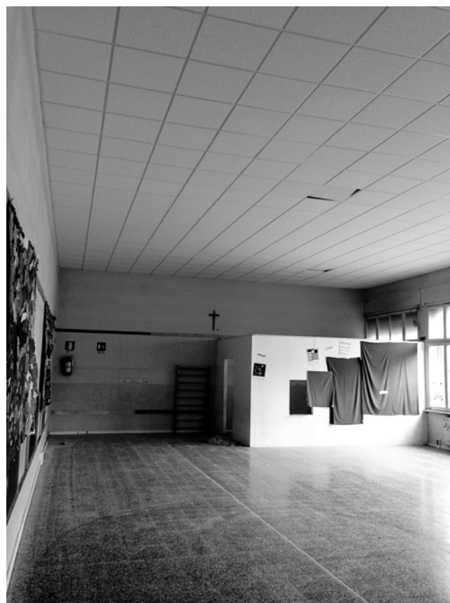
Ribassamento del soffitto del salone della scuola materna per interventi di efficientamento energetico.
